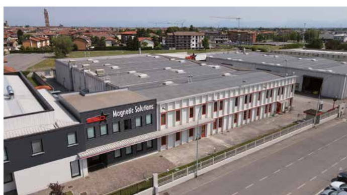
SEDE PRODUTTIVA 1 - PRODUCTION FACILITIES 1
