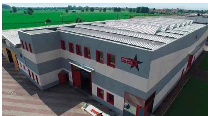
SEDE PRODUTTIVA 2 - PRODUCTION FACILITIES 2
