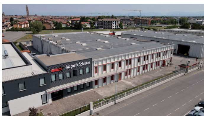
SEDE PRODUTTIVA 1 - PRODUCTION FACILITIES 1
