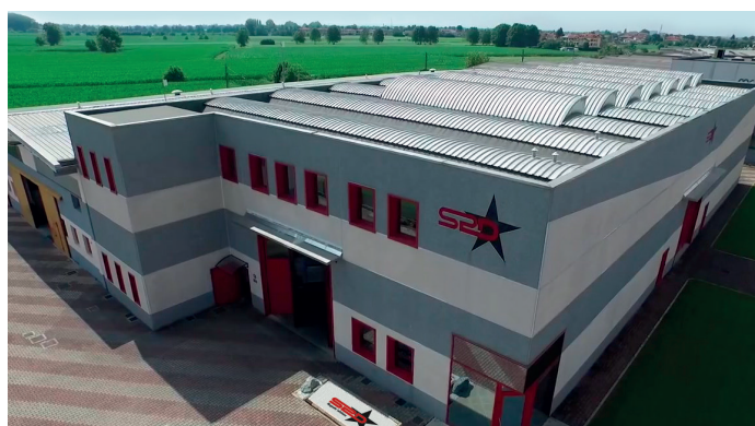
SEDE PRODUTTIVA 2 - PRODUCTION FACILITIES 2
