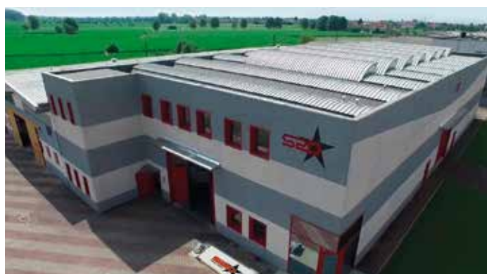
SEDE PRODUTTIVA 2 - PRODUCTION FACILITIES 2
