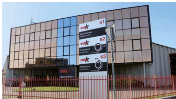
SEDE AMMINISTRATIVA - HEADQUARTER
