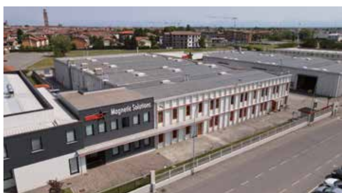
SEDE PRODUTTIVA 1 - PRODUCTION FACILITIES 1
