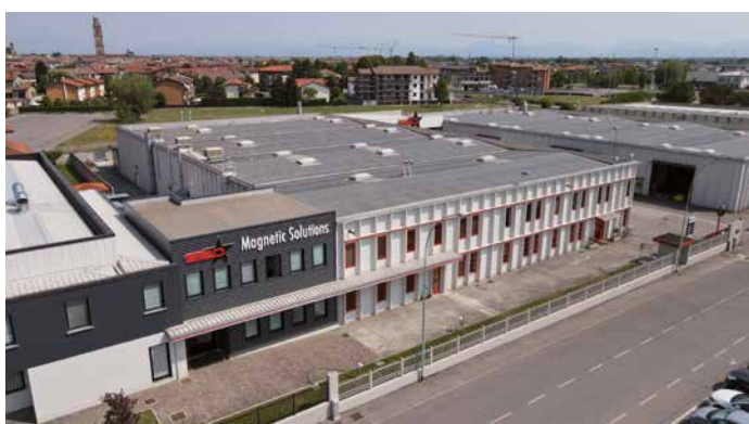
SEDE PRODUTTIVA 1 - PRODUCTION FACILITIES 1
